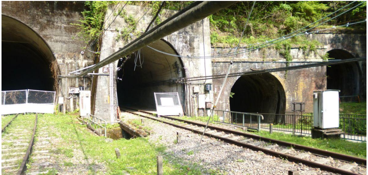
【旧熊ノ平駅のトンネル 左の 2 つが複線化のトンネル、右の 2 つがアプト式のトンネル】
