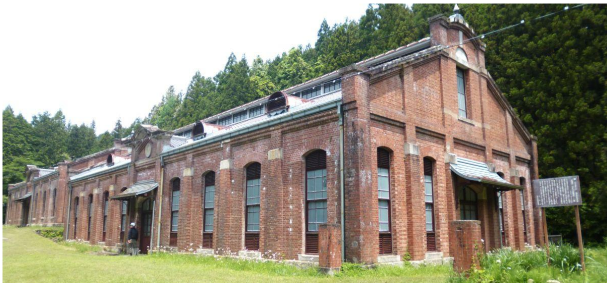
【旧丸山変電所】
