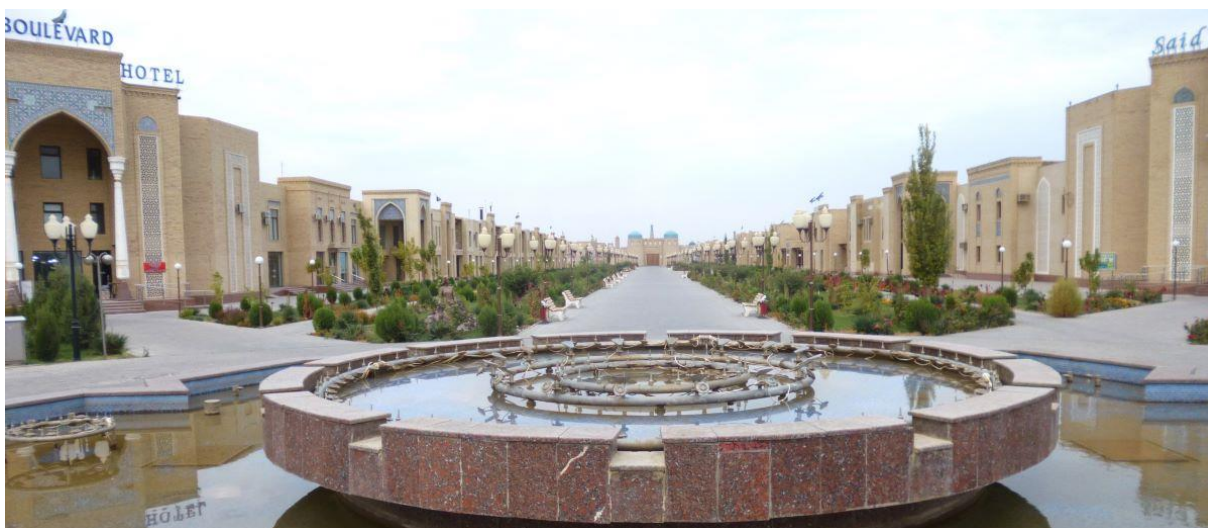
【ホテル団地の中央通路 手前は噴水で水は出ていない】
