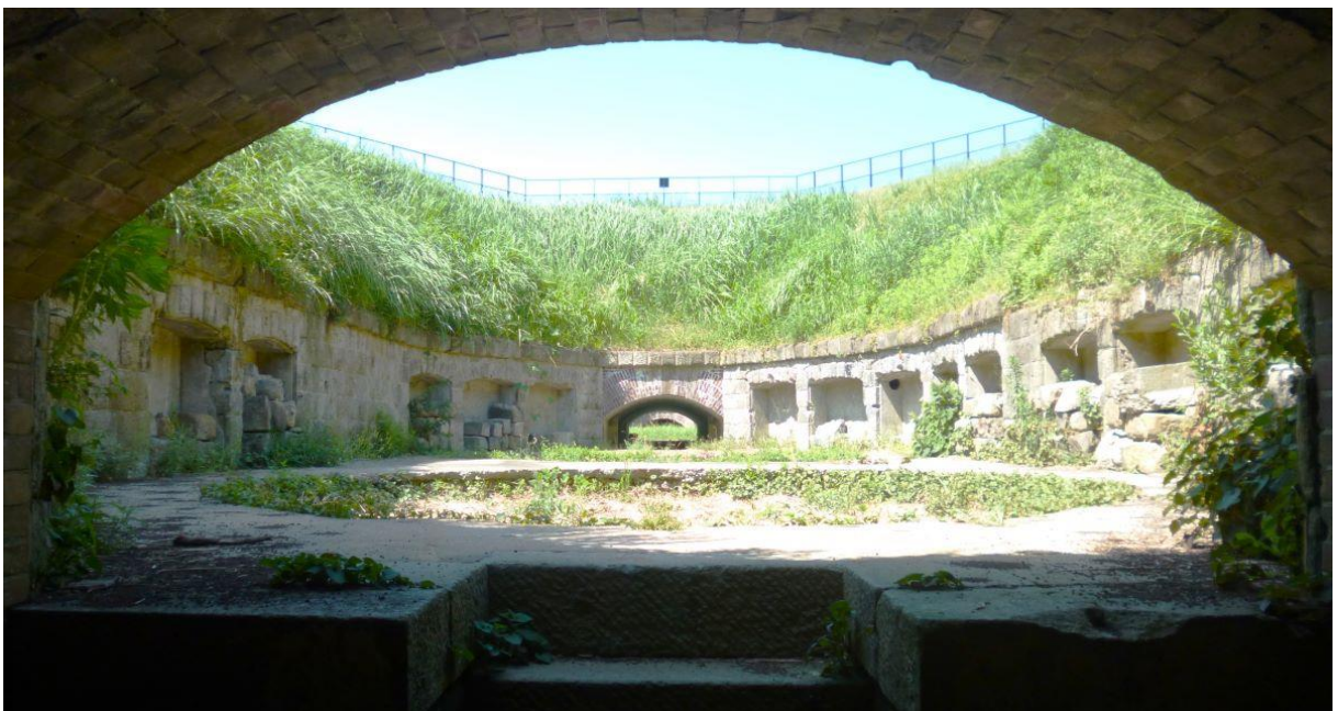
【地下道から砲座が置かれた穴を見る】
