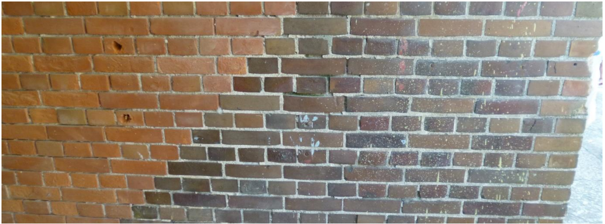
【イギリス積みのレンガ 右の黒いレンガが焼き過ぎレンガ】
