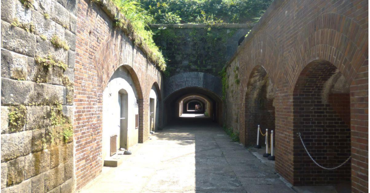
【レンガ造りの地下道】
