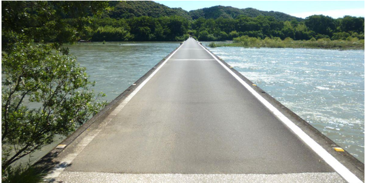
【佐田の沈下橋】
