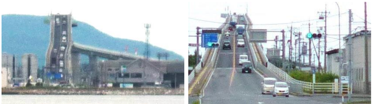
【江島大橋の遠景と近景】
