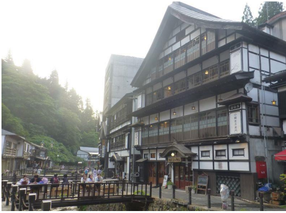
【古勢起屋別館の外観 前に橋がある】
