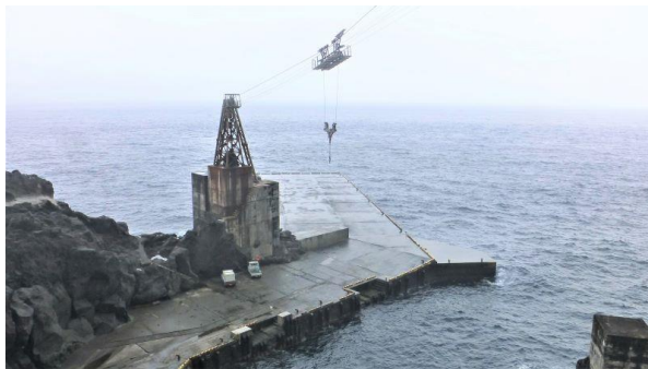
【漁船を吊り上げるクレーンの片側】
