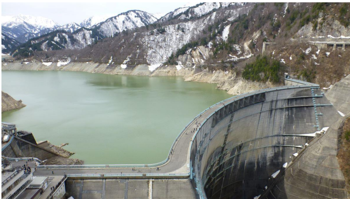
【黒部ダム全景 堤防の上の道を歩く人々 堤防のウイングも見える】
