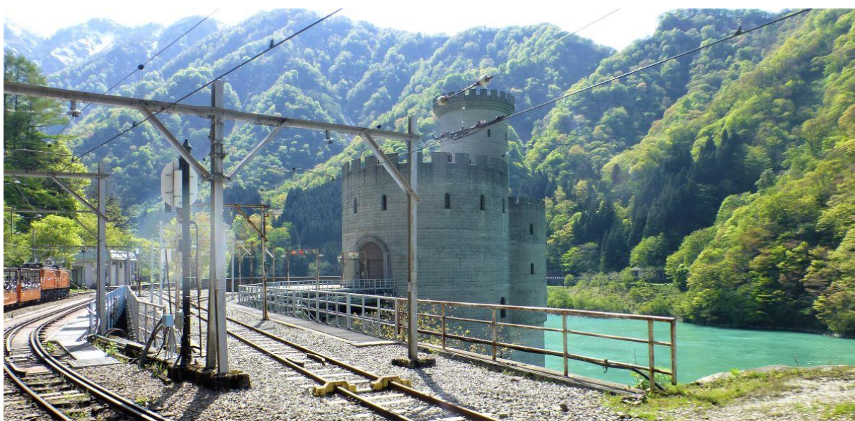
【新柳河原発電所】
