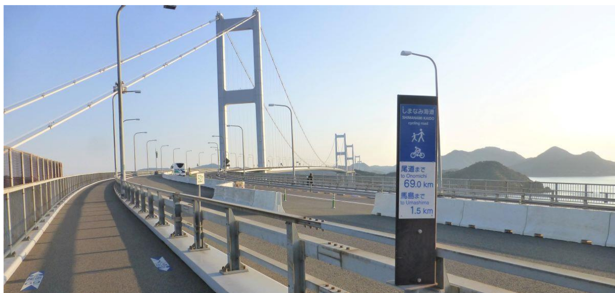
【来島海峡大橋の第三橋 左が自転車兼歩行者用道路で対面通行になっている】
