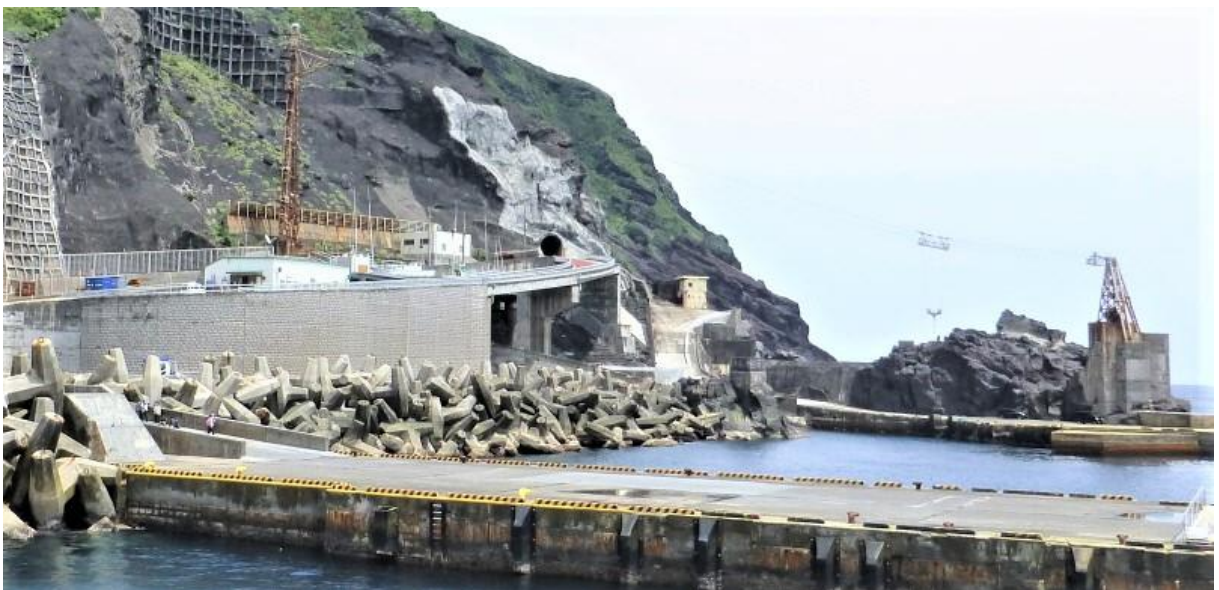
【青ヶ島の港 手前の栈橋の奥に漁船用の栈橋、クレーンとトンネル横に漁船も見える】
