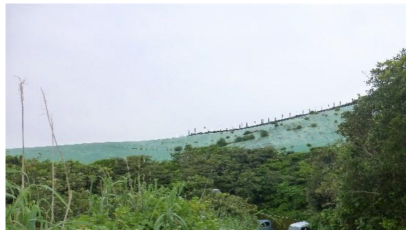
【尾山展望広場近くの雨水集水場】
