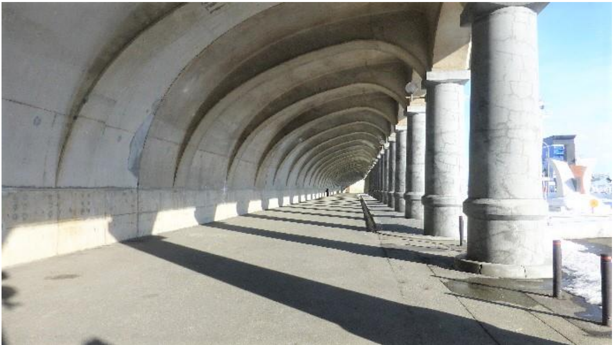
【北防波堤ドーム 中央から片側を撮っている】
