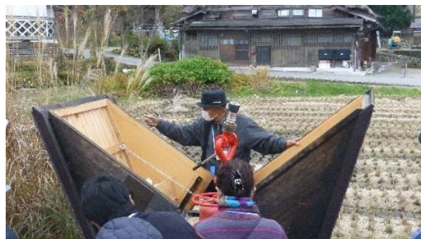
【格納されている放水銃】
