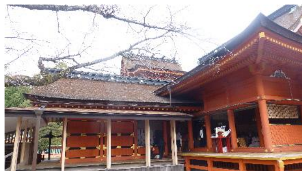
【徳川家康が寄進した 2 階建ての本殿】
