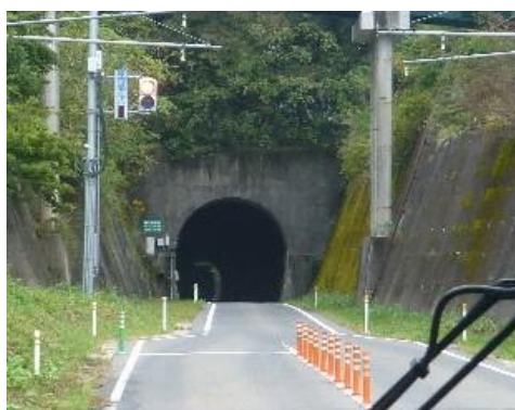
【舗装した列車用トンネルと信号】
