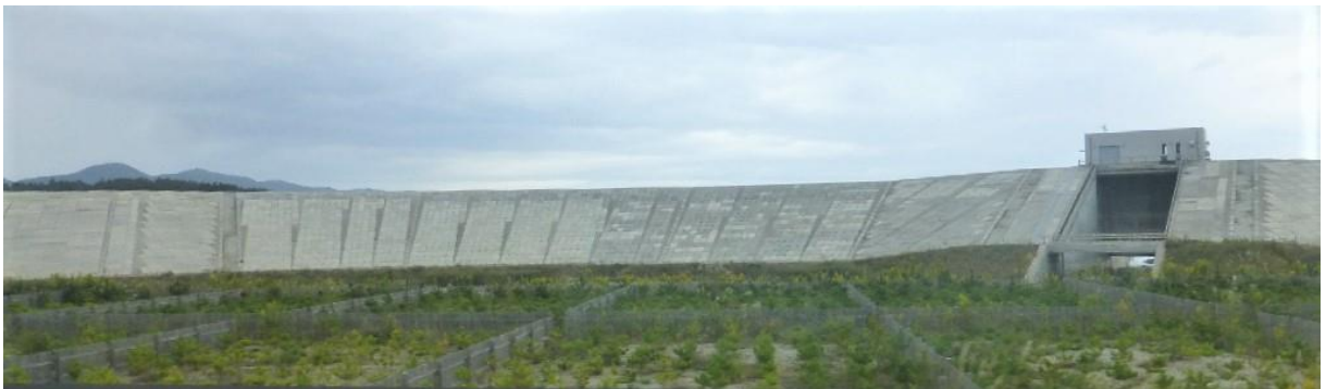
【高さ 10m 以上の防潮堤 奇跡の一本松付近】
