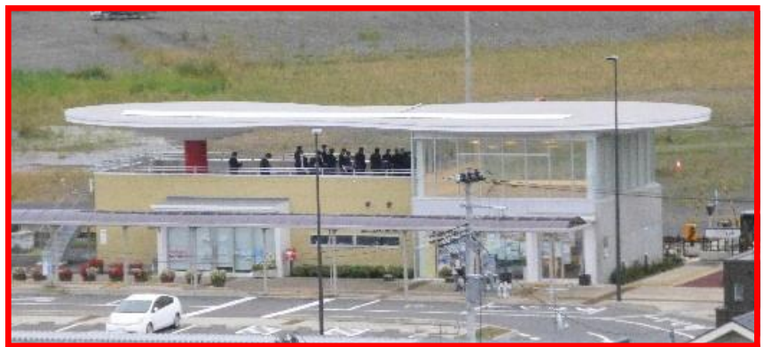
【大槌駅の駅舎】
