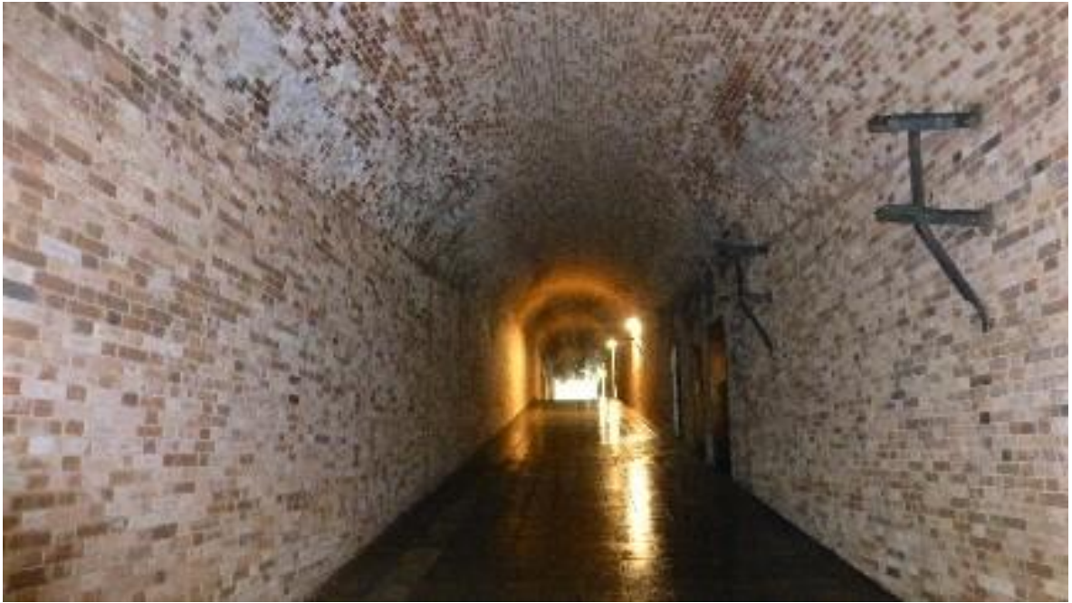
<照明が点いたレンガ造りのトンネル>
