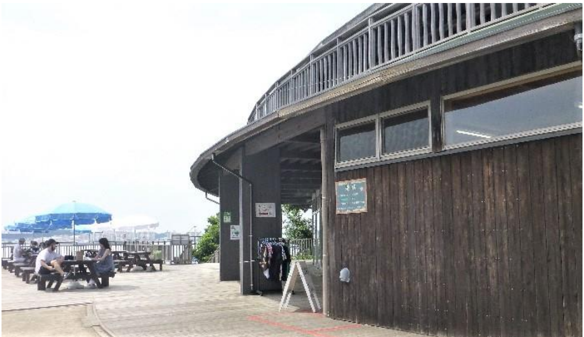
<船着き場付近のウッドデッキと建物>
