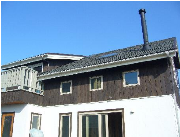
【建設途中の大川邸 2010年】
