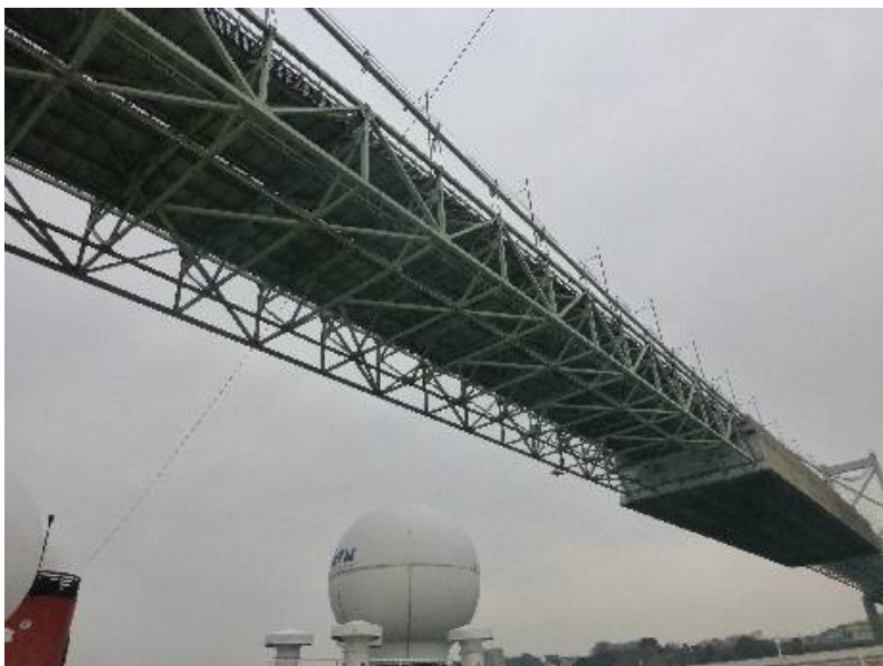
【写真 11】 関門橋の下を通過する船のデッキからの光景
