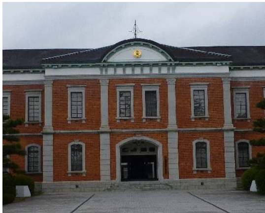
【写真 14】幹部候補生学校庁舎
