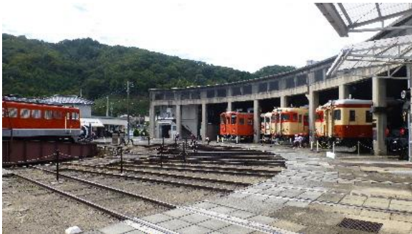
< 転車台と扇方の機関車車庫 >
